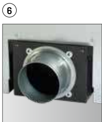
6 Entrada de aire exterior.
